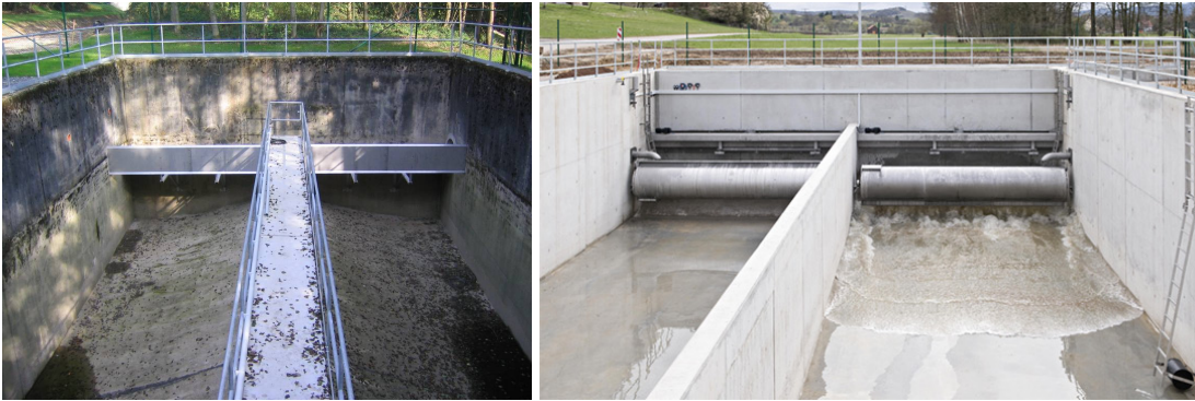
Abbildung 11: Leeres und leicht gefülltes Überlaufbecken.
